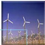
L'énergie éolienne est produite grâce à la force exercée par le vent sur les pales d'une hélice. Cette hélice est montée sur un mât de 50 à 110 mètres de haut, et le diamètre du cercle balayé par les 3 pales varie de 40 à 120 mètres.
